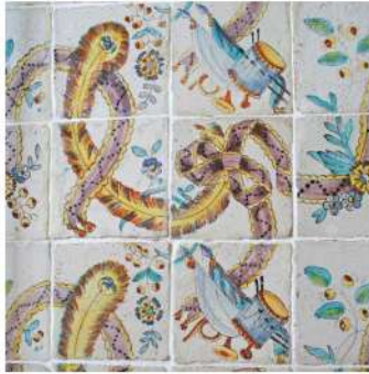
Suelo de azulejos del salón, de estilo rococó. Siglo XVIII.
